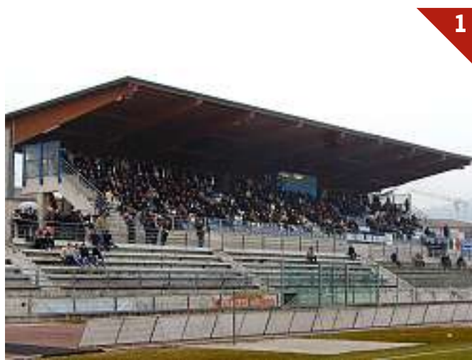
LA CORNICE. Il pubblico delle grandi occasioni ha gremito la tribuna dello stadio Turina. Una derby particolarmente sentito da parte di due tifoserie amiche che hanno sottolineato la loro vicinanza.
